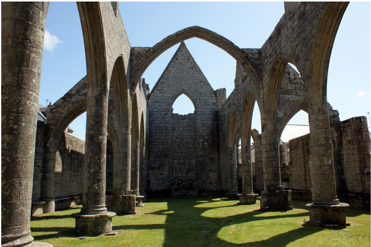
La Chapelle du Mûrier, vue de l'intérieur
